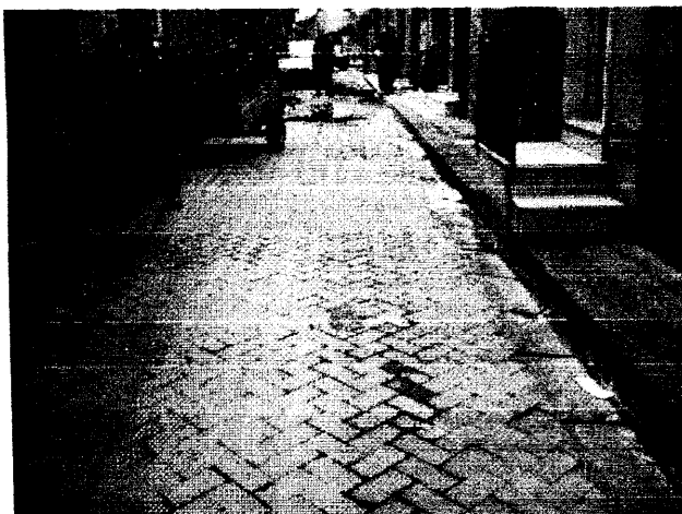
Tratto sede stradale sostituz. Condotta
