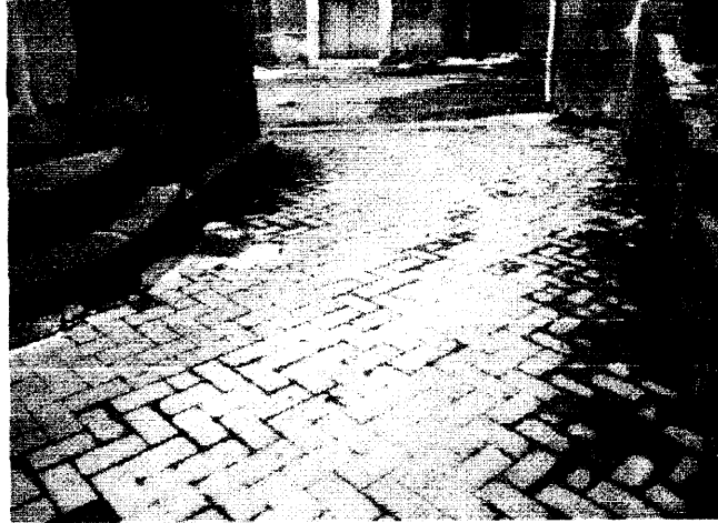
Tratto sede stradale sostituz.. condotta con incrocio Via L. Vasi
