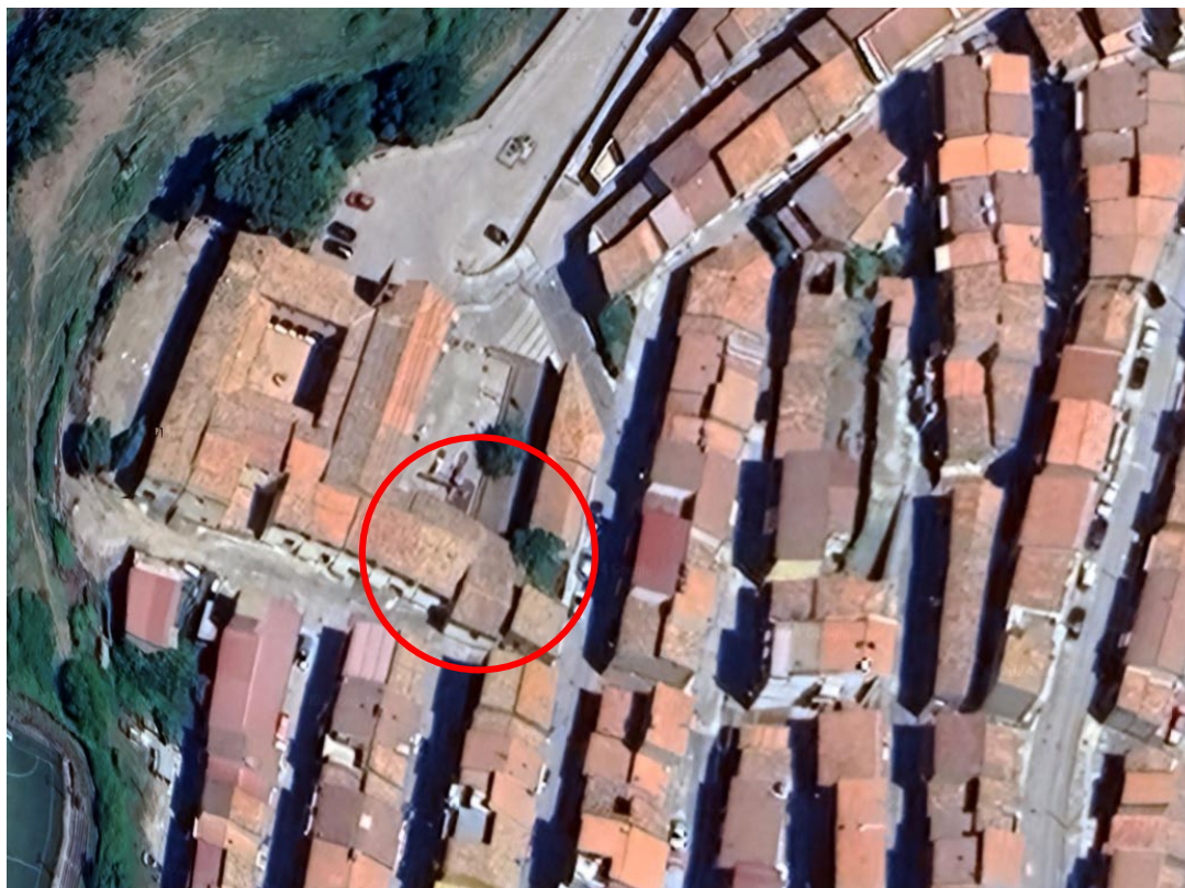
Figura 2 - Vista aerea dell'area oggetto d'intervento
