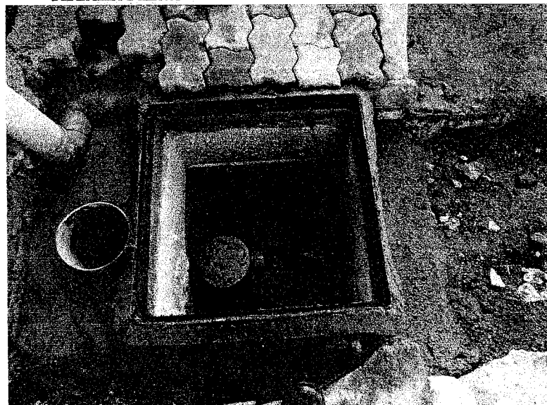
Particolare pozzetto sifonato
